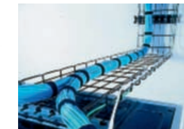
Cablofil wire mesh cable tray
